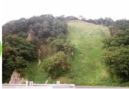
[平成 10 年度完成] 山腹工（連続繊維補強土工）により 斜面の補強を図る。
