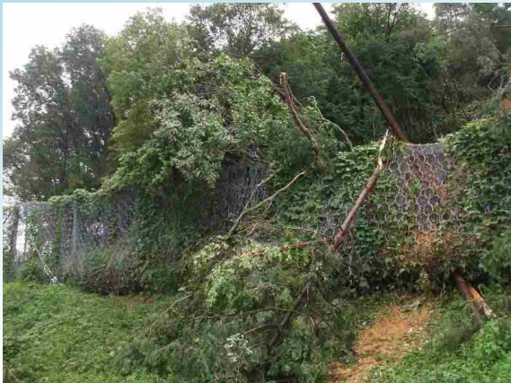
台風第 11 号の豪雨により斜面崩壊が発生したが、落石防護柵が土砂を捕捉し斜面直下の人家の被災を防いだ。
