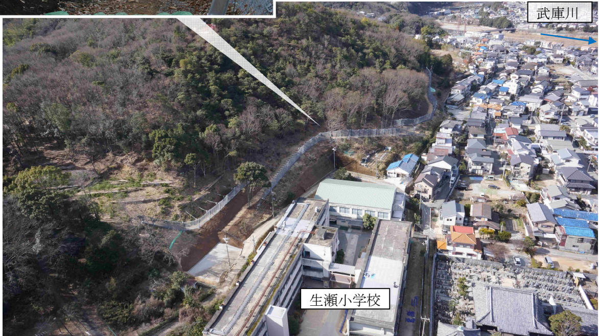
〔平成 24 年度〕 山林を保全し、山裾部で崩壊土砂を受け止める斜面对策
