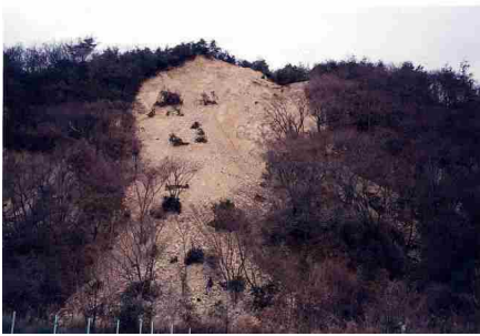
[平成 7 年] 地震直後の山腹崩壊状況
