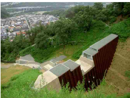
[平成 18 年完成] 土石流から多数の人家を保全
