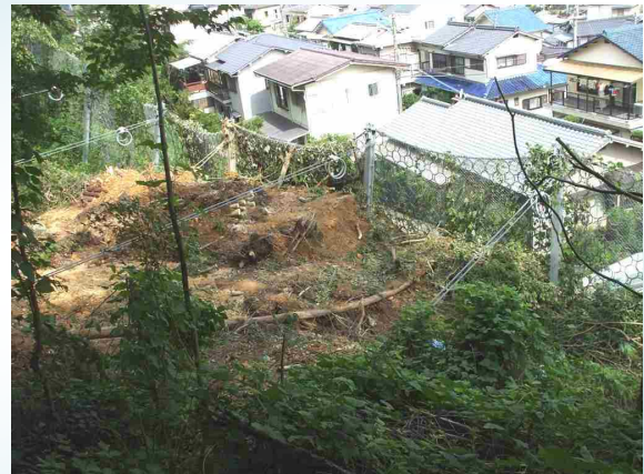
台風第 11 号の豪雨により斜面崩壊が発生したが、落石防護柵が土砂を捕捉し斜面直下の人家の被災を防いだ。
