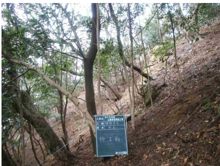
山腹工施工前の状況
