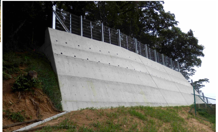
[H26 年度完成] 人家裏にある急斜面からの崩壊土砂や落石より人家を守る。
