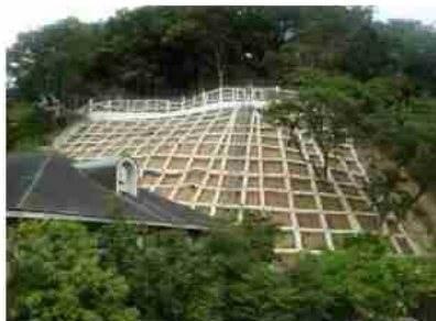
[平成 23 年度完成] 山腹工施工直後の状況
