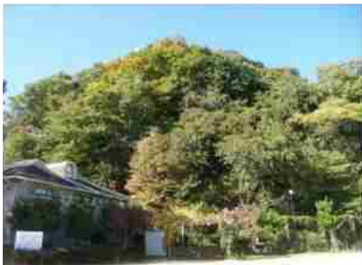
山腹工施工前の状況 土砂災害の恐れがある斜面
