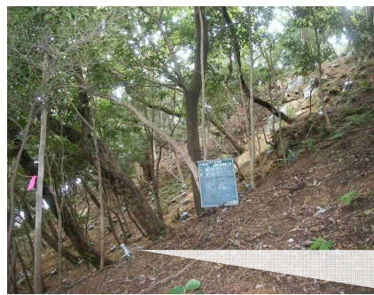
[平成 23 年度完成] ノンレーム工法 対策後も現存の樹林が残り、景観を損なわない
