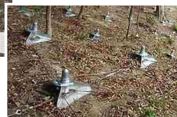
[平成 23 年度完成] ノンレーム工法 対策後も現存の樹林が残り、景観を損なわない
