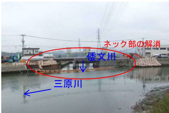
3 南あわじ市松帆江尻地内
