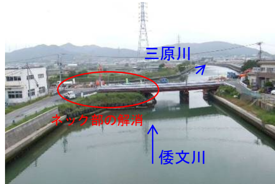
4 南あわじ市松帆江尻地内
