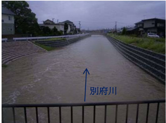
2 加古川市加古川町大野地内
