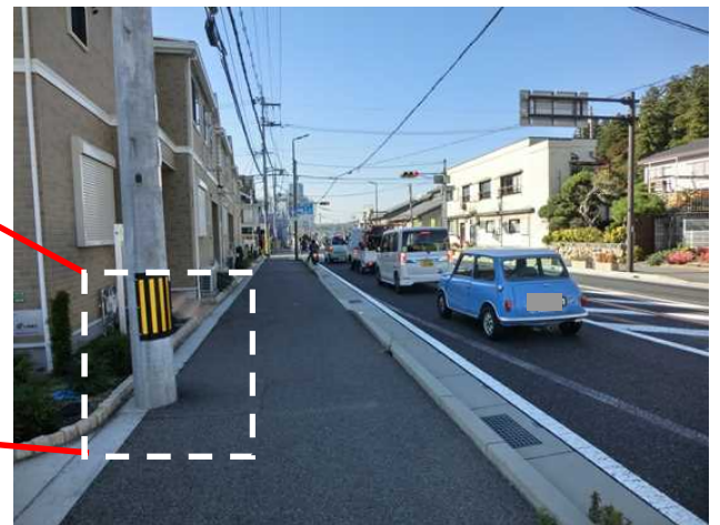
道路区域内の電柱(境界ブロックと一体構造の例)
