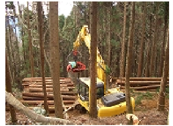
高性能林業機械による搬出間伐
