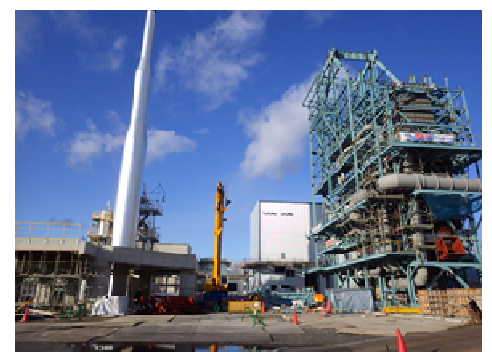
建設中の木質バイオマス発電所 (赤穂市)
