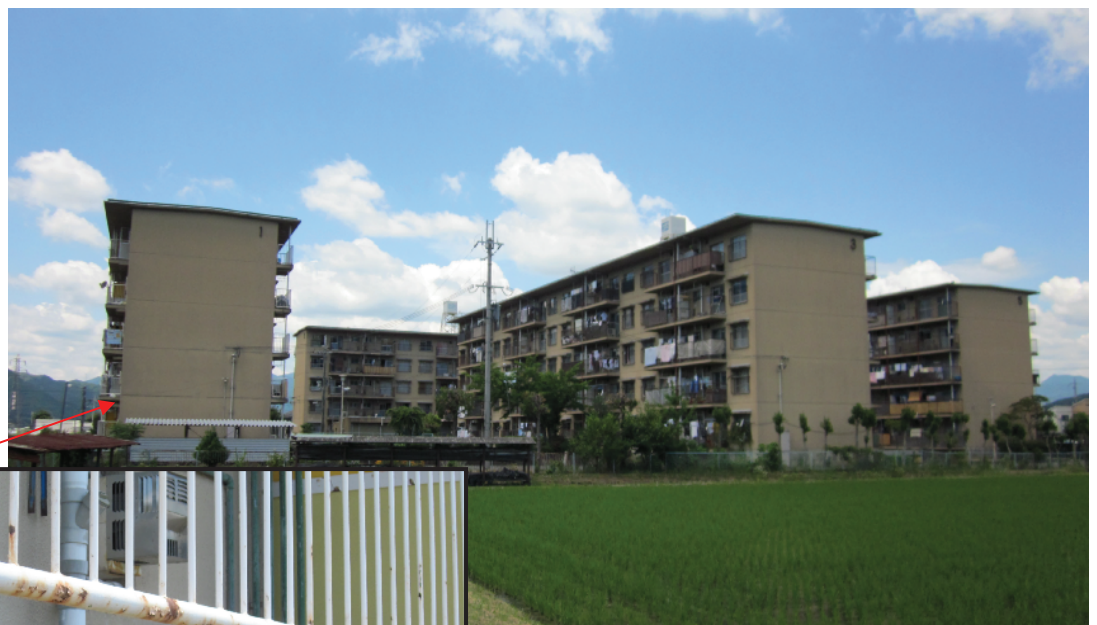
外観 2 : 住棟南東側
