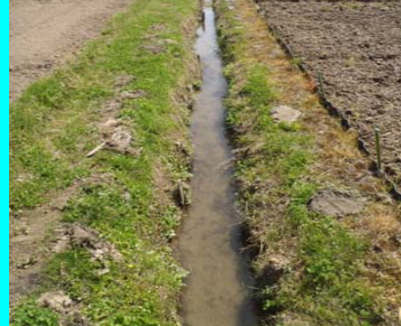
土水路で排水路兼用のため維持管理に苦慮している
