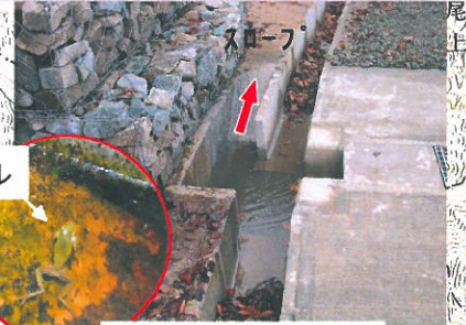
スロープ付き水路
