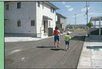
新たに整備された地区内区画道路
