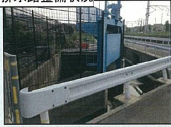
排水路整備状況
