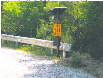
■林道へ監視カメラの設置
