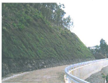
■自然環境に配慮した法面緑化
