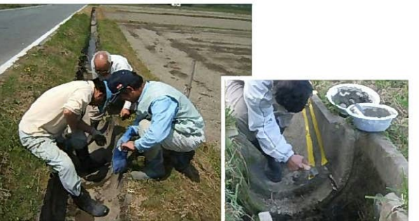
用水路の老朽化(目地補修作業) 農地・水・環境保全向上活動により、用水路の点検、補修をおこなっていますが、水路の老朽化は予想以上に進んでおり全面改修・パイプライン化することになりました。
