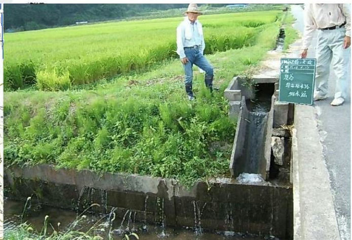
用水路の老朽化(漏水状況) パイプライン化により水路沿いの湿地状況が解消され、収量の増及び小豆・大豆の作付面積増が見込まれます。
