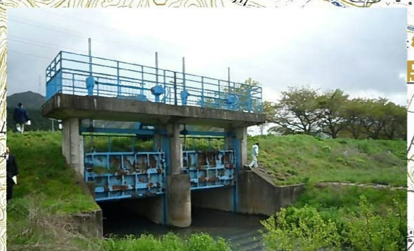
排水樋門操作の電動化 排水樋門は現在手動で操作しているが、開閉に時間がかかり、また操作者が高齢化していることから電動化を図る。
