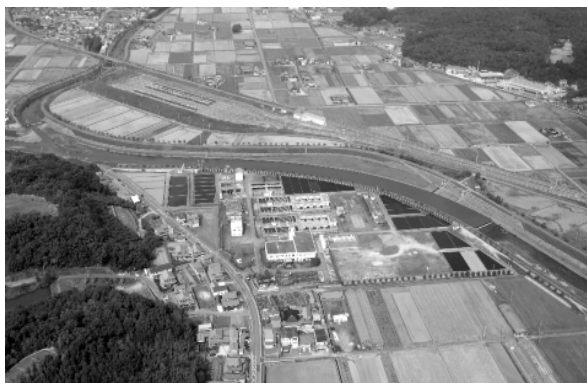
三田浄水場(三田市)
