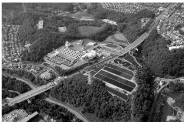
多田浄水場(川西市)
