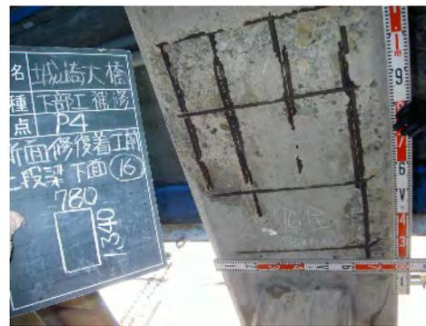
橋脚鉄筋露出
