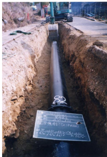
写真2 ダムから受益地へのパイプライン施工状況
