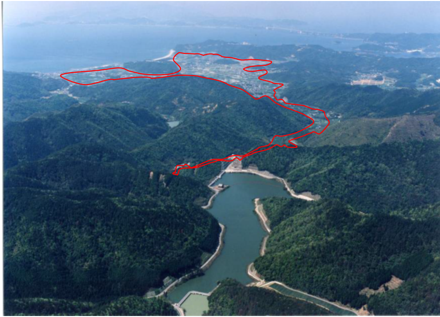
写真1 本庄川ダムと受益地
