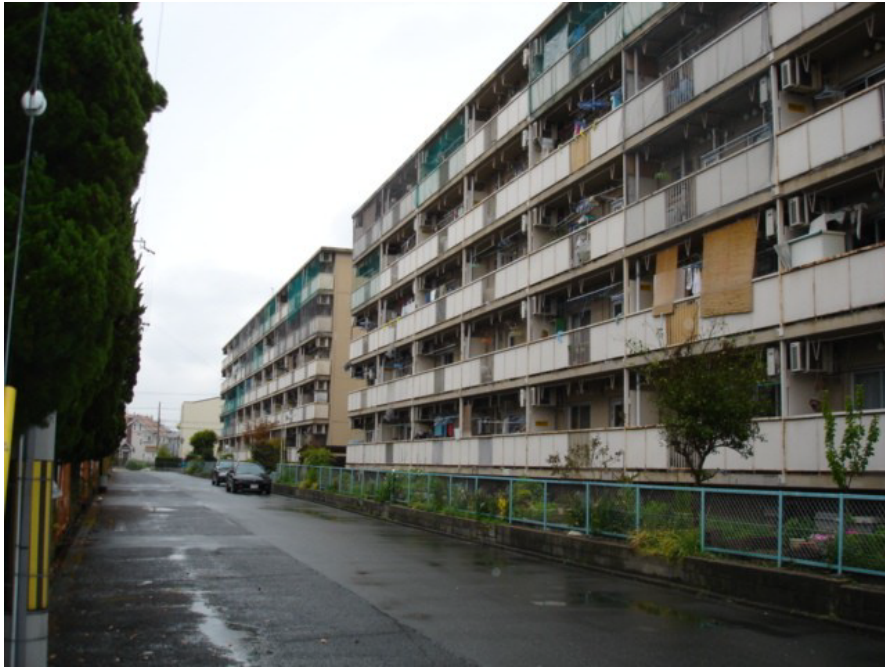
伊丹野間鉄筋住宅現状写真 外観：住棟南側
