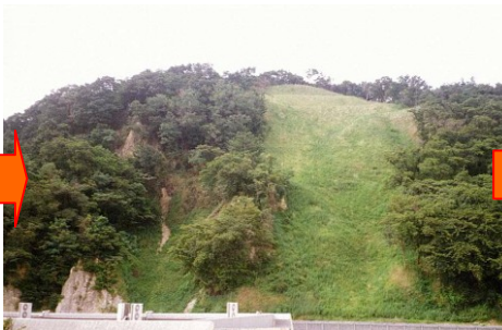
山腹工（連続繊維補強土工）により 斜面の補強を図る。 [平成 10 年]
