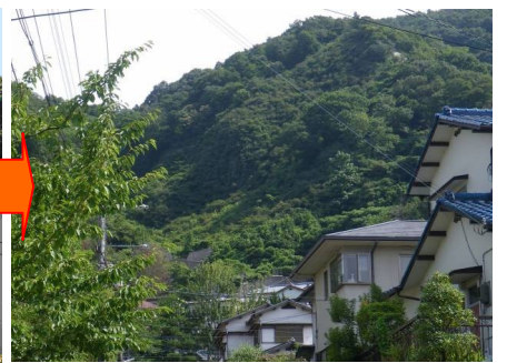
緑が復元した現在の状況 法枠工は緑に隠されている。 [平成 21 年]
