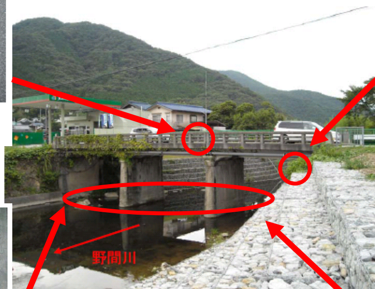
高欄コンクリートの剥離と露筋の状況
