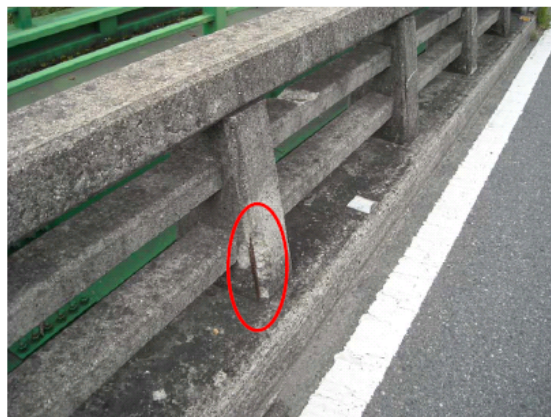
高欄コンクリートの剥離と露筋の状況
