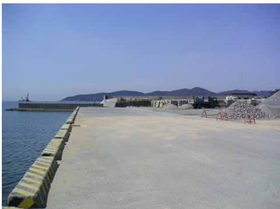
事業箇所岸壁の現況
