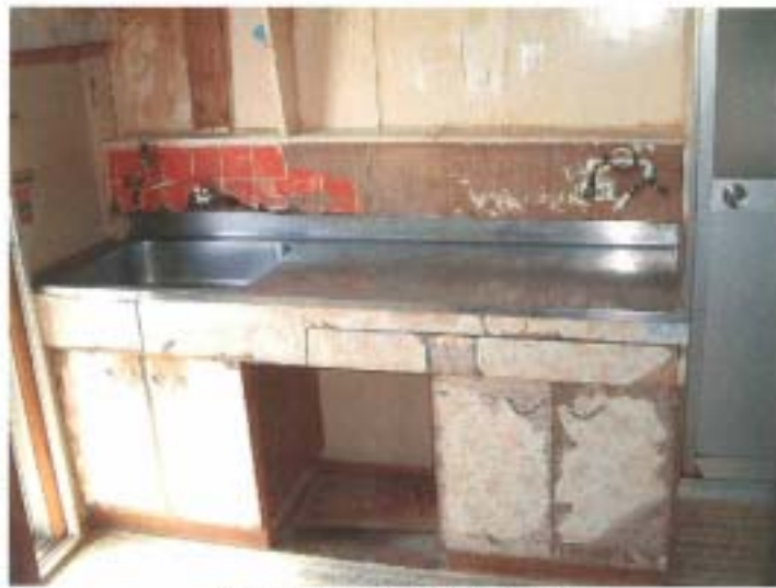
伊丹小松原鉄筋団地現状写真 内部：キッチン
