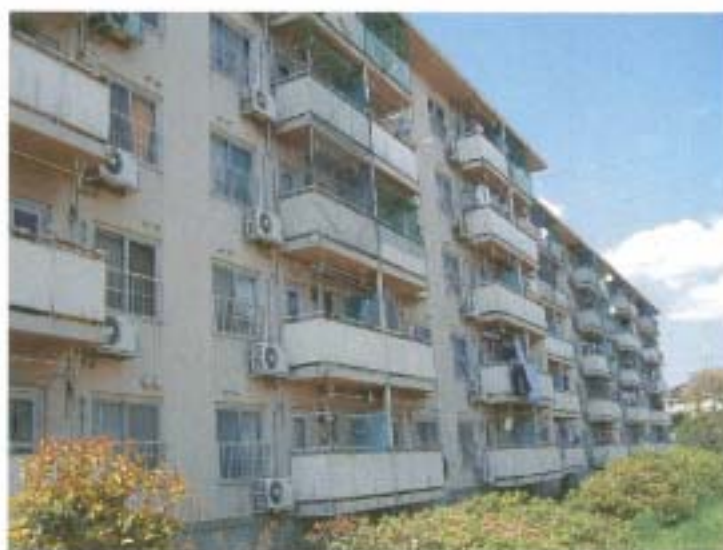
伊丹小松原鉄筋団地現状写真 外観：住棟南面を望む
