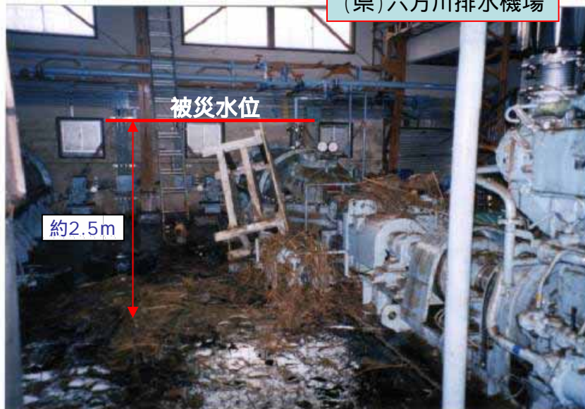
(県)六方川排水機場
