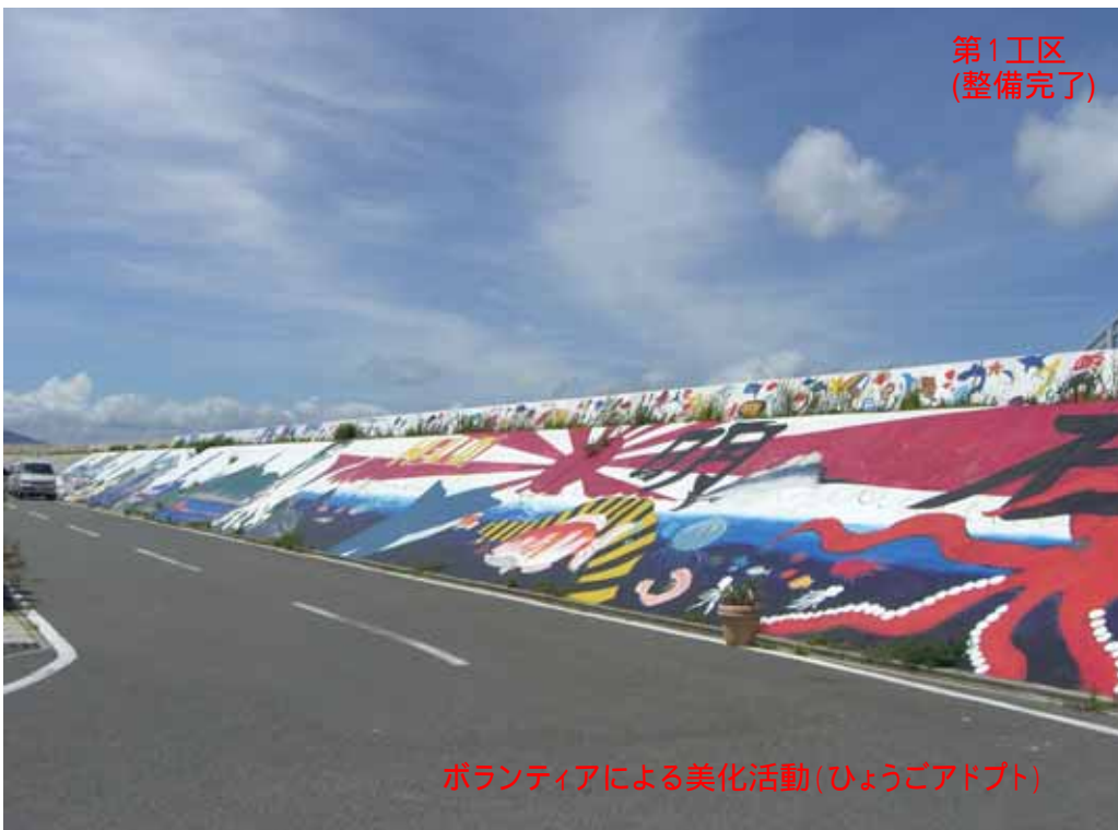
現況 (整備完了箇所)
