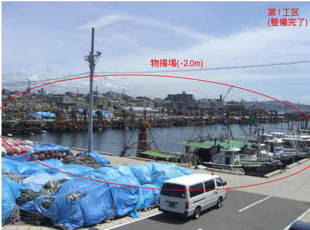
現況 (整備完了箇所)
