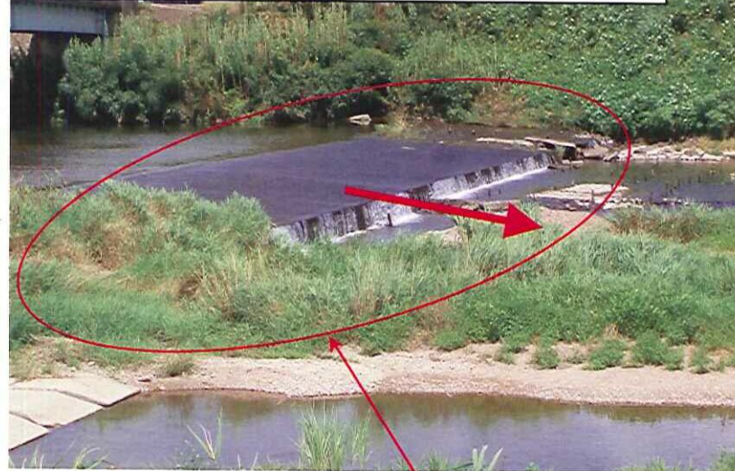
【高町井堰(第3統合可動堰)】
