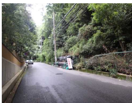
③崩壊状況
