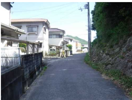
②保全対象とがけの状況
