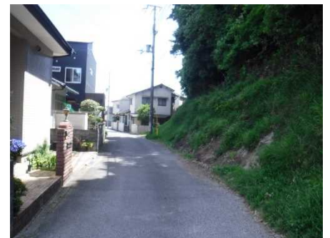
④保全対象とがけの状況
