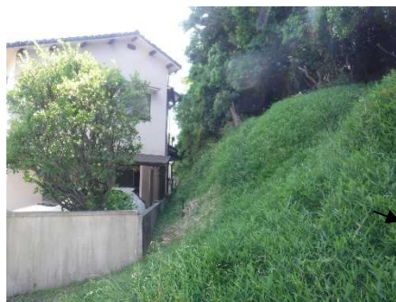
③保全対象とがけの状況
