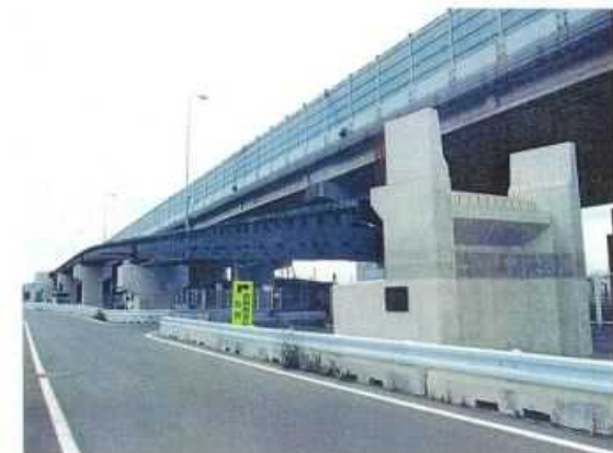
苦蘆地区北側側道橋工事風景
