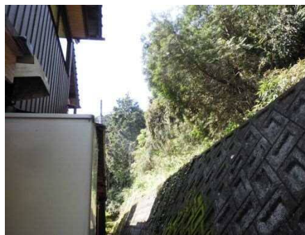
③斜面状況(中間部)
