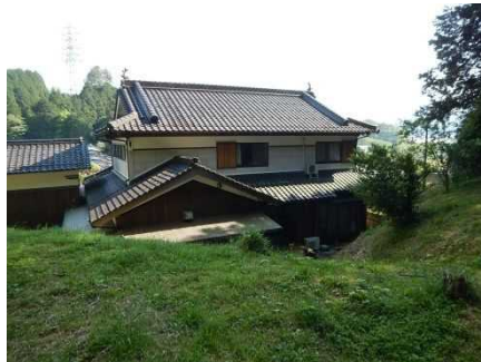
③保全対象とがけの状況
