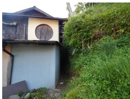
③保全対象とがけの状況
