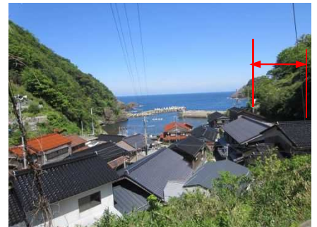
③保全対象(人家)
