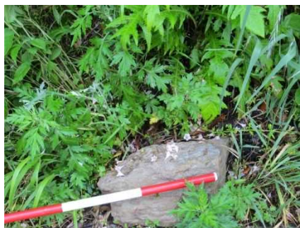
②斜面状況(転石状況)
