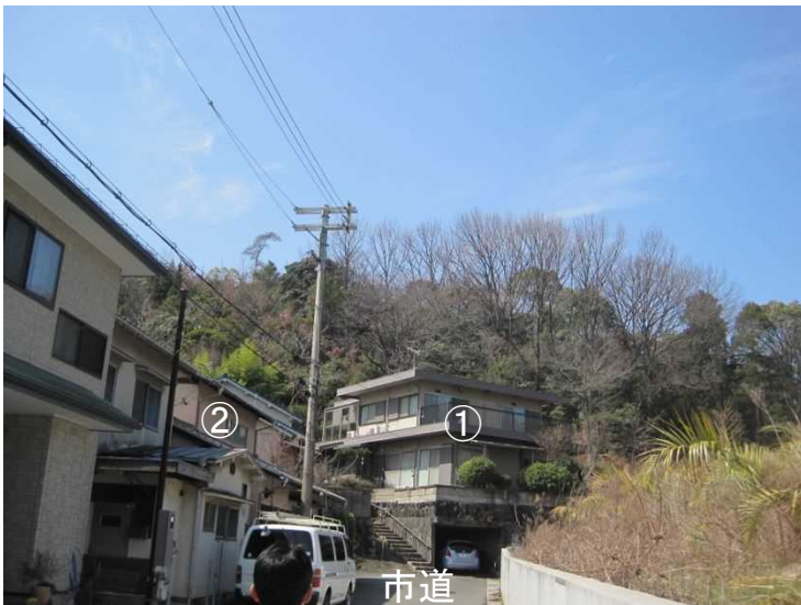
D 保全対象人家
