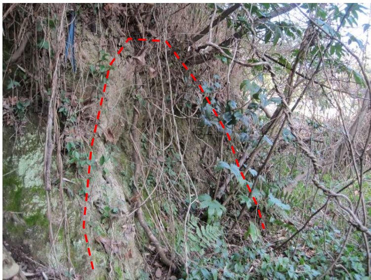
E 斜面崩壊箇所
