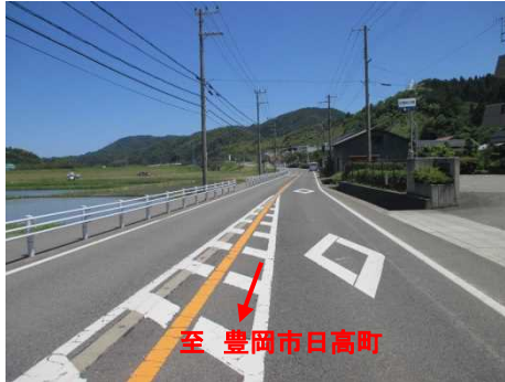
③ 北側改良区間(2車線片側歩道有)
