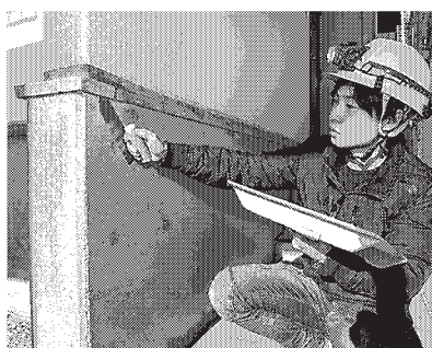
団地の共用部分の壁にモルタルを塗る丹治さん
