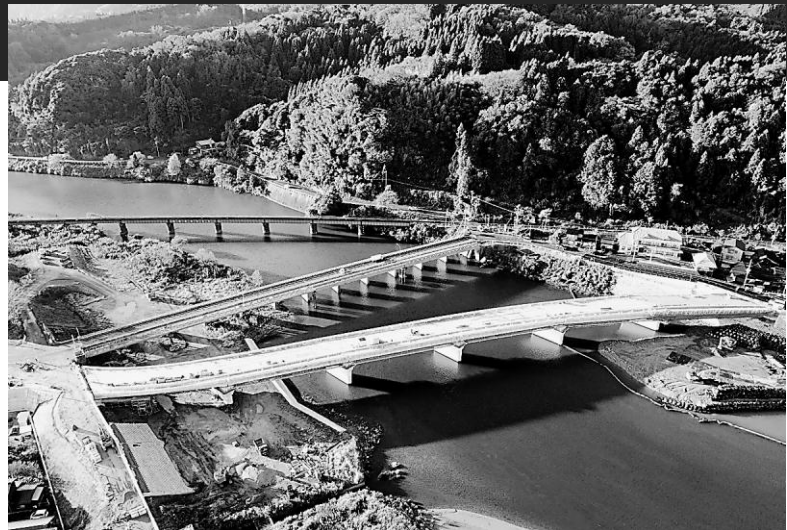
架け替え工事の進む矢田橋。香住中心部と茶部方面をつなぐ矢田橋の架け替え工事が進んでいる。河口側に建設中の新しい橋の完成後、築70年近くが経過した今の橋を撤去する計画だ。2023年度に開通予定の新しい橋は車道部の幅が今より3m広くなり、耐震性も向上する。工事を発注した兵庫県と受注側の施工業者に、事業内容や建設業の魅力を尋ねた。
