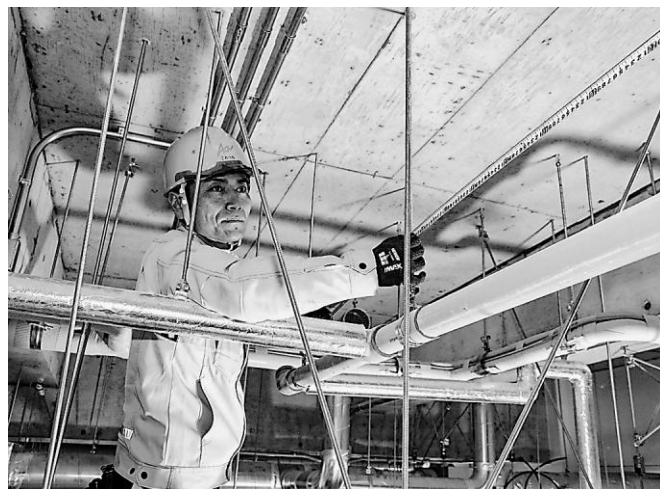
空調設備の配管の長さや間隔が施工図通りに設置されているかを探する是常央征さん
