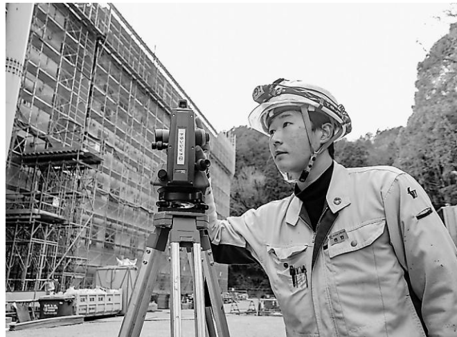
建物の角度を測量機器で確認する楞野尚人さん。角度のずれは距離が長くなると大きな誤差になる
