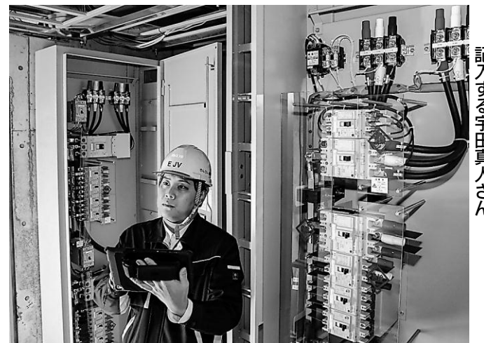
電気設備が基準を満たしているかをテストして結果をタブレットに記入する宇田真人さん
