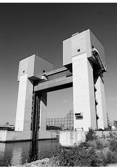
西宮市南部を流れる新川と東川の河口部で2014年に着工、26年度末に完工予定。南海トラフ巨大地震で県は3m以上の津波を想定しており、津波が川をさかのぼって浸水する被害を軽減するために新たに整備した水門が21年に完成。排水能力が約2倍になる統合排水機場と海沿いの防潮堤ができれば、浸水面積が419haから37haに縮小する。
