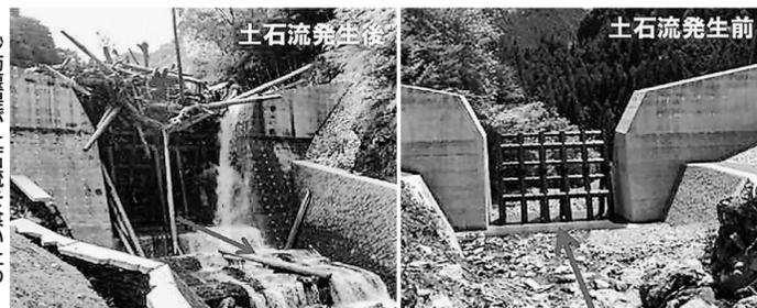
砂防堰堤が土石流を食い止めた事例。矢印は水流の方向(安来市波賀町小野、2018年7月豪雨)
