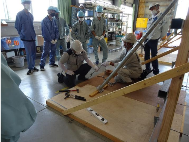
型枠(擁壁)の組立て
