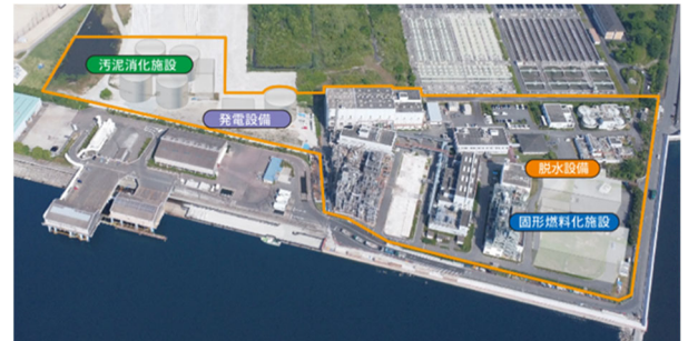
兵庫東流域下水汚泥広域処理場（尼崎市） 下水汚泥エネルギー有効利用施設 イメージ図
