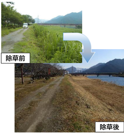
河川堤防の点検前除草（丹波市）
