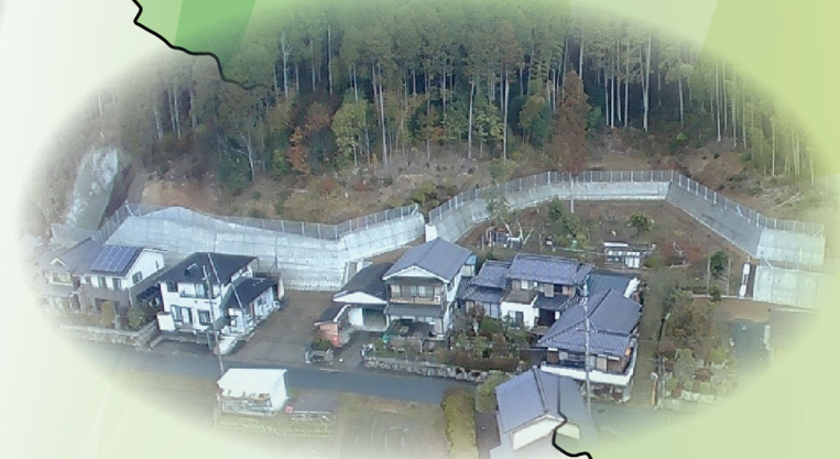
犬岡地区 急傾斜地崩壊対策 (丹波市)
