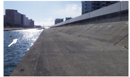
尼崎西宮芦屋港海岸（西宮市）
