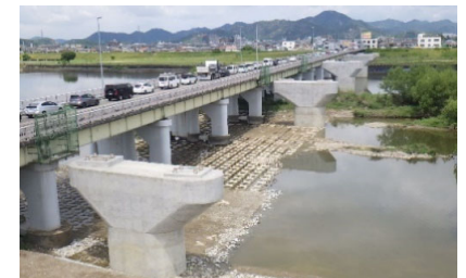
都市計画道路 国道2号線 加古川橋（加古川市）
