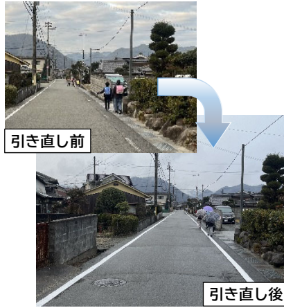
道路区画線の引き直し（西脇市）
