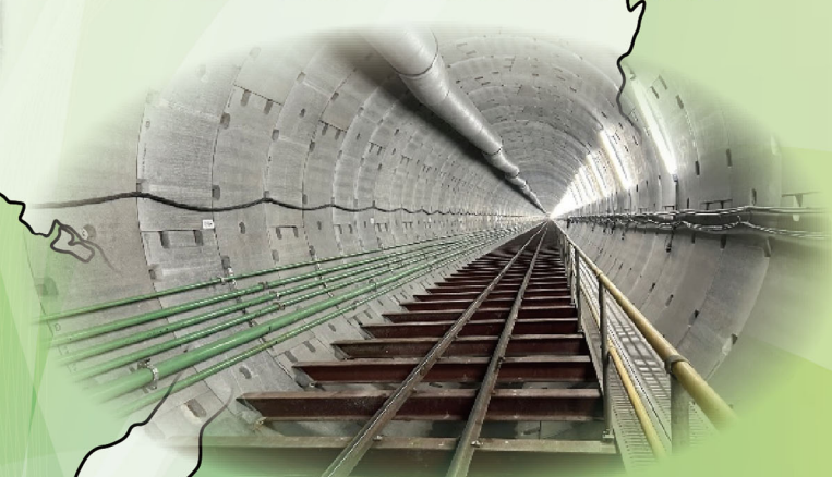
津門川 地下貯留管 (西宮市)
