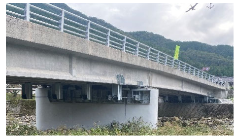
県道 加美穴栗線 山田橋 橋梁耐震補強 (神河町)
