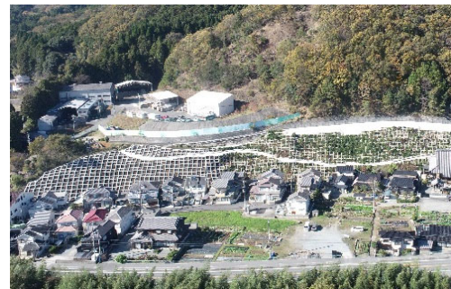
五十波地区 急傾斜地対策（宍粟市）
