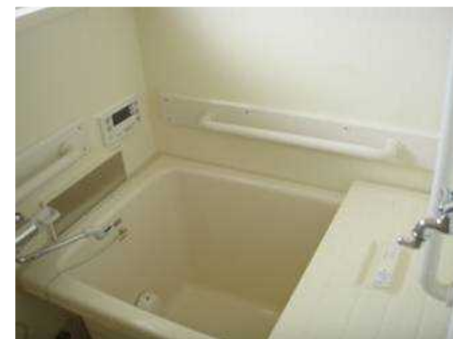
浴室の改修工事 (手すり設置、浴槽入替え)
