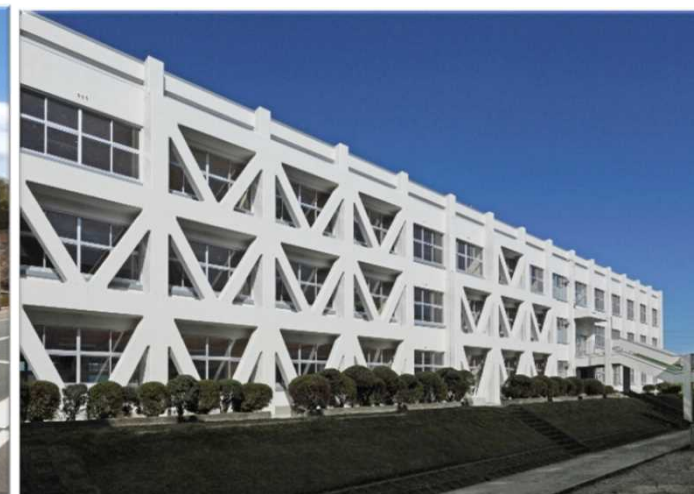
洲本実業高校耐震改修
