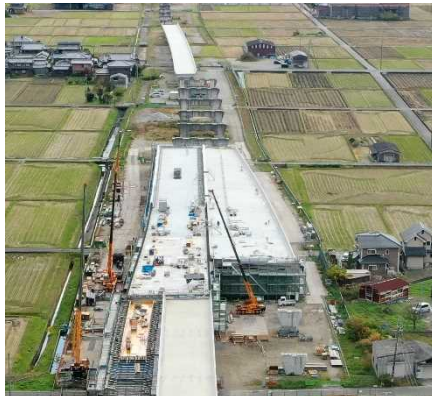
津万高架橋（西脇市）
