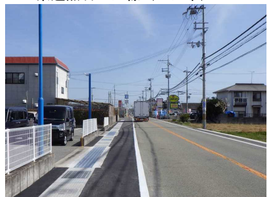
路肩拡幅 県道本荘平岡線 (加古川市)
