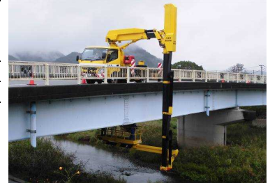
橋梁点検車による点検
