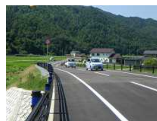
県道関宮小代線 吉井バイパス(養父市)
