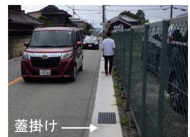
側溝蓋がけによる 歩行空間の確保 県道宗佐土山線（稲美町）
