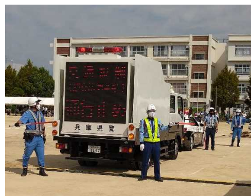
道路啓開訓練 (サインカー出動)
