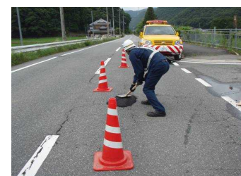
道路パトロールによる路面補修
