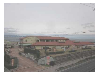
道の駅「あわじ」(淡路市)
