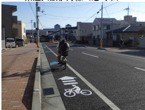
車道混在 県道中山寺停車場線 (宝塚市)
