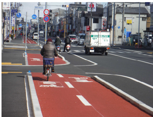
自転車道 県道大阪伊丹線 (尼崎市)
