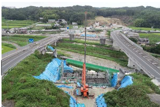
菅野高架橋（神戸市）
