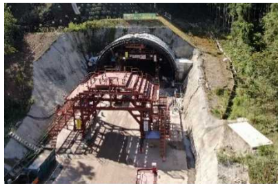
豊岡道路 戸牧トンネル(R3.7.28貫通)(豊岡市)
