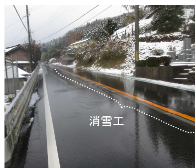
消雪工 国道 178 号 (豊岡市)
