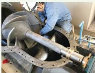
排水ポンプの分解・補修(南あわじ市慶野)
