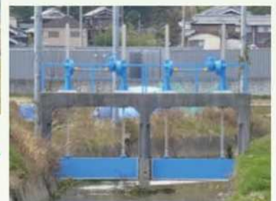
樋門の更新(三木市別所)
