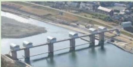
河川から農業用水を取水する井堰(たつの市北村頭首工)
