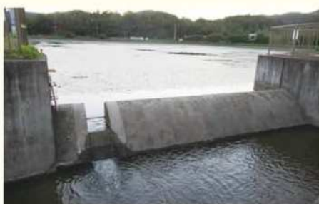
洪水吐に切欠を設け、あらかじめ満水位を低下（高砂市惣毛池）
