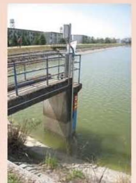
水位の遠隔監視(明石市釜谷池)
