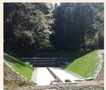
利用されなくなった危険なため池の廃止(朝来市妙見谷池)
