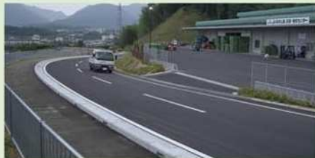
大型車両での輸送が可能な農道(南あわじ市みどり地区)
