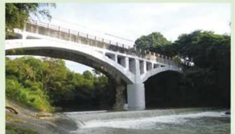
耐震補強された御坂サイフォン (三木市志染町)
