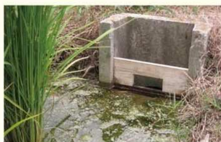
セキ板を設置し、豪雨時に田んぼからの排水量を低減（赤穂市周世ほか）
