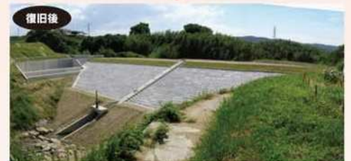
平成16年台風23号で被災したため池の復旧(淡路市下川池)
