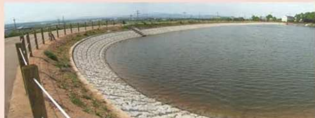
改修が完了したため池(小野市浄谷北池)
