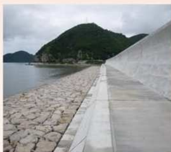
高潮対策のための海岸堤防(赤穂市福浦)
