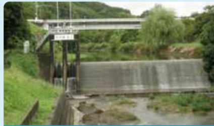
頭首工：川をせき止めて水を取る施設
