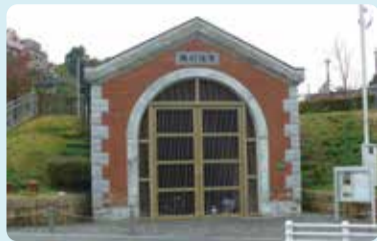
湊川隧道呑口
