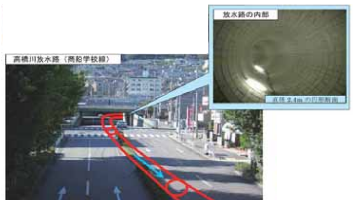
図 2.4.1 高橋川放水路
