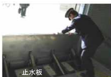
図 7.4.2 止水板、止水鉄扉の設置（神戸市営地下鉄）
