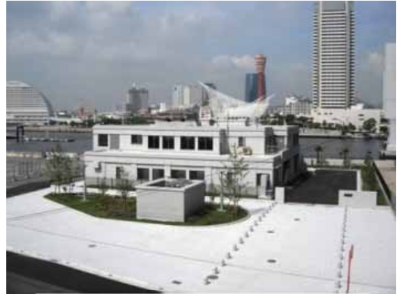
図 2.4.18 京橋ポンプ場
