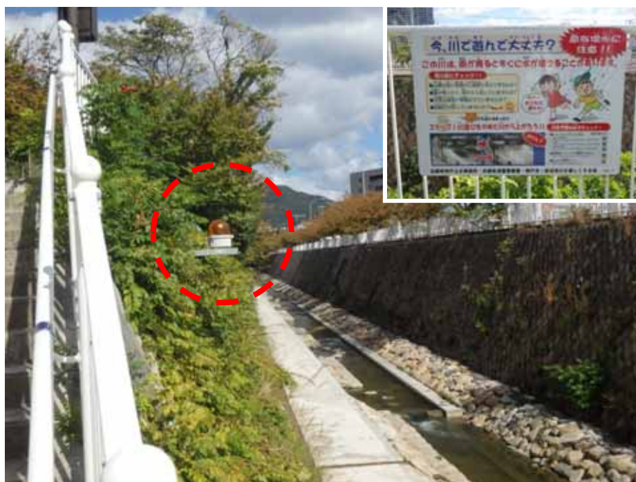
図 7.2.1 回転灯の設置(妙法寺川)
