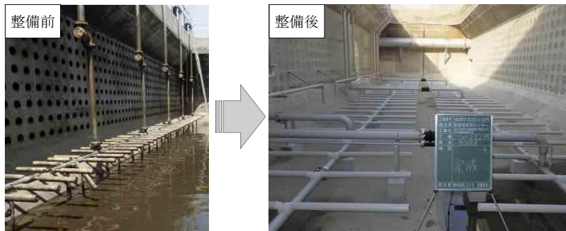
老朽化した散気装置を更新
