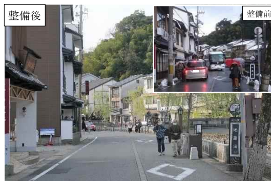
無電柱化対策
