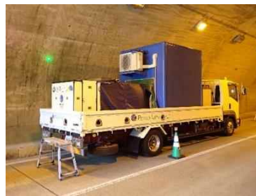
トンネル点検(レーザー打音)
