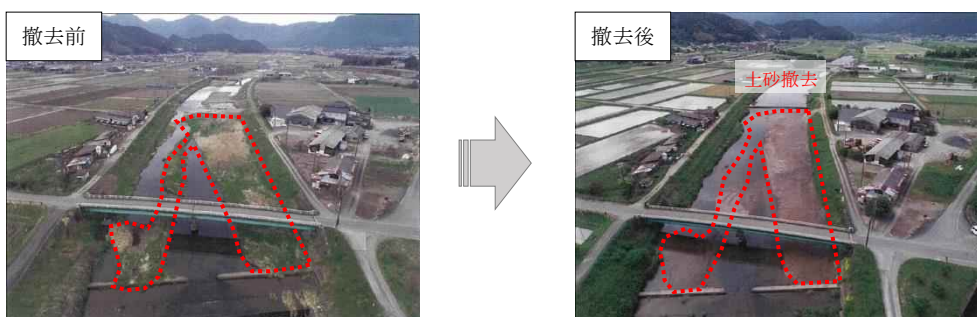
堆積土砂撤去
