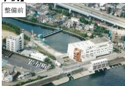
排水機場(更新)
