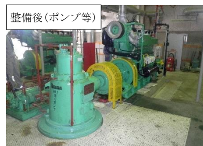
排水機場(ポンプ等修繕)
