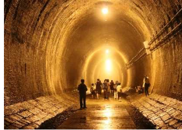
隧道の中を見学
