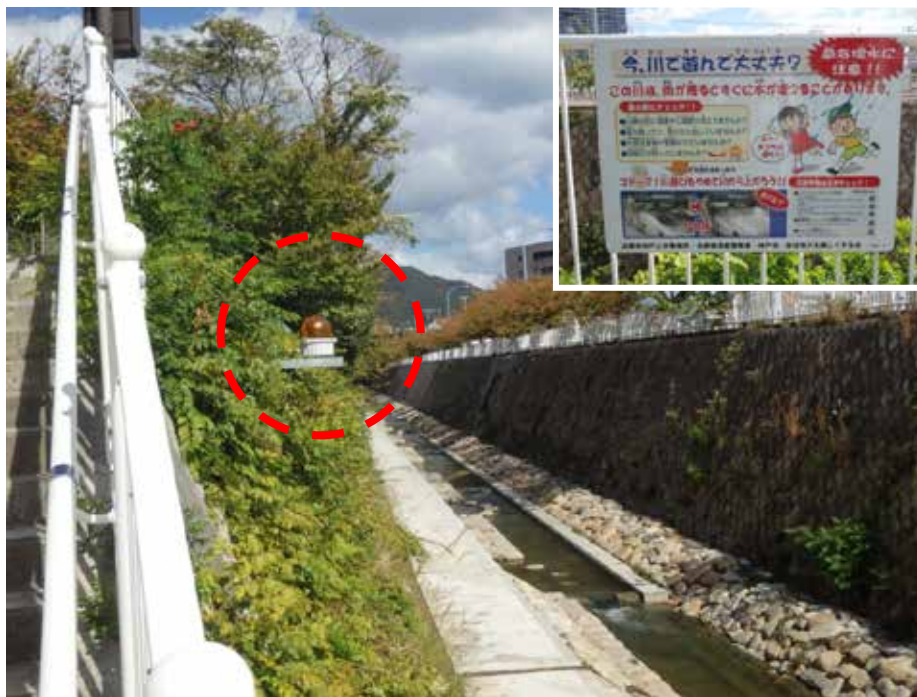
図 7.2.1 回転灯の設置(妙法寺川)
