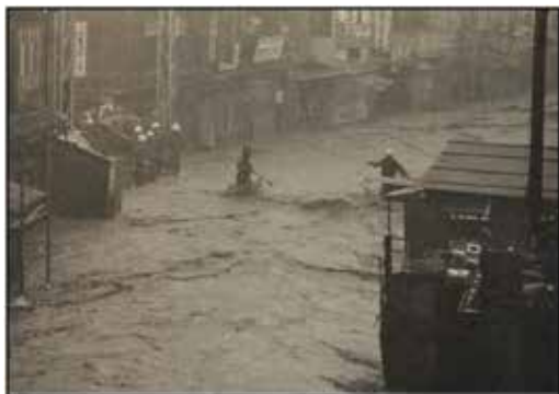
中央区下山手通 9 丁目付近の様子
