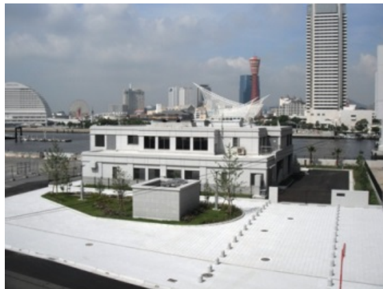
図 2.4.18 京橋ポンプ場
