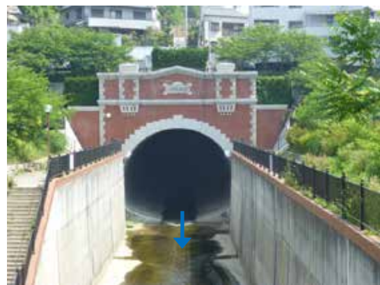
図 2.4.10 湊川隧道（新湊川） 【吐口側】
