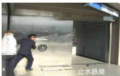
図 7.4.2 止水板、止水鉄扉の設置（神戸市営地下鉄）
