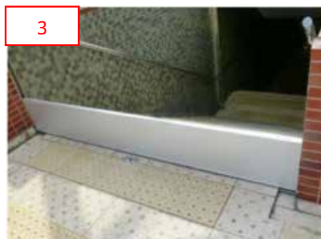
図 7.4.3 止水板の設置（デュオこうべ）
