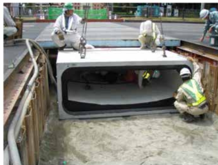
図 5.2.3 雨水幹線の整備 (神戸アクアプラン 2015)
