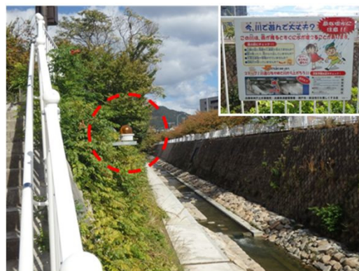
増水警報装置（妙法寺川）
