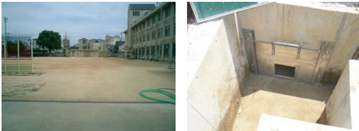
図 2.5.1 真陽小学校における流出調整機能施設(オリフィス)の整備
