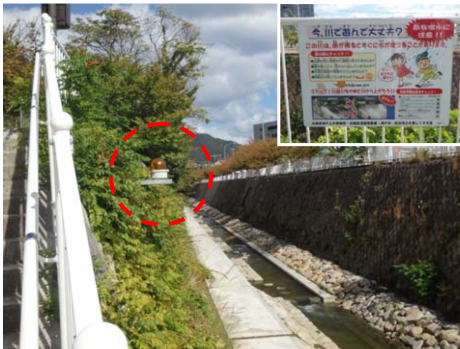
図 7.2.1 回転灯の設置 (妙法寺川)
