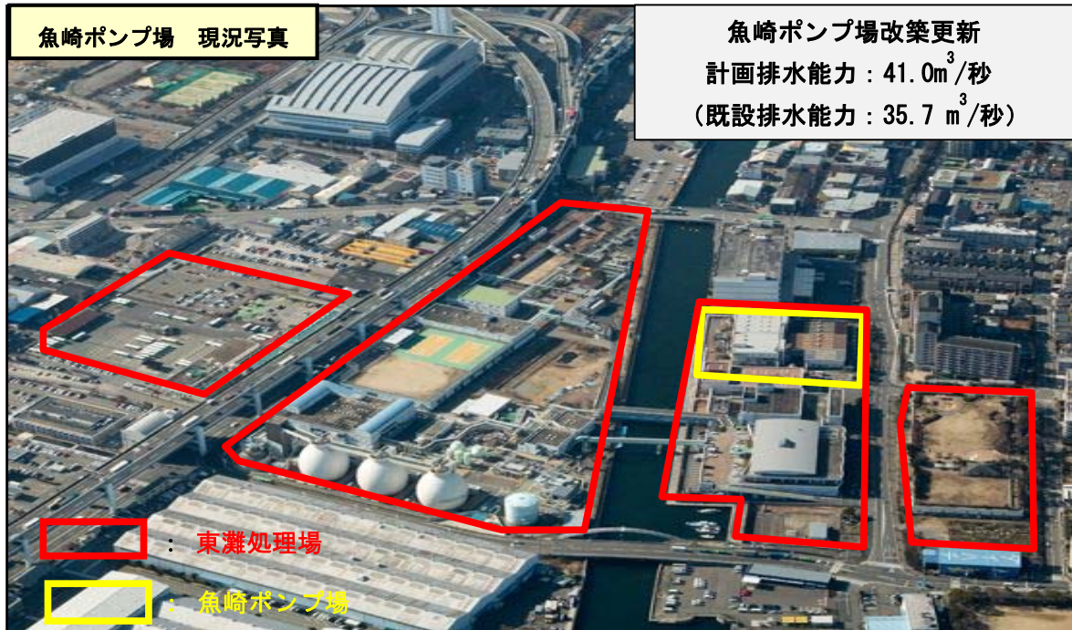
図 5.2.2 ポンプ場の改築（こうべアクアプラン 2020）
