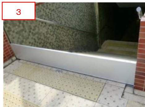
図 7.4.2 止水板の設置 (デュオこうべ)
