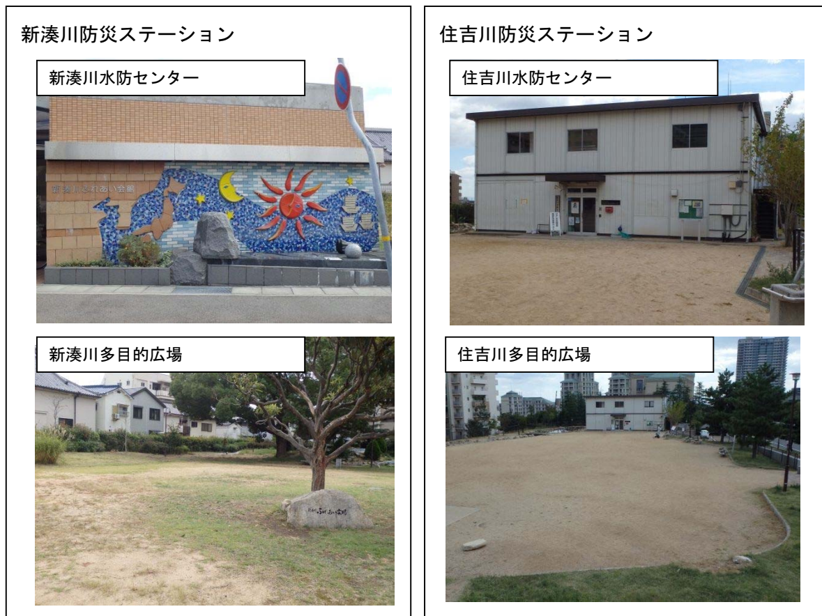
図 7.2.19 河川防災ステーション
